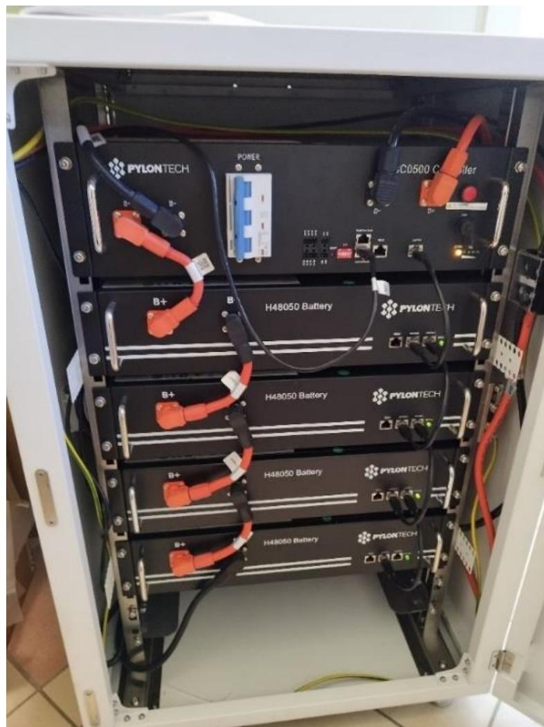
Slika 5.8. Upravljač baterijskog sustava PylonTech SC0500 s paketom baterija H48050
