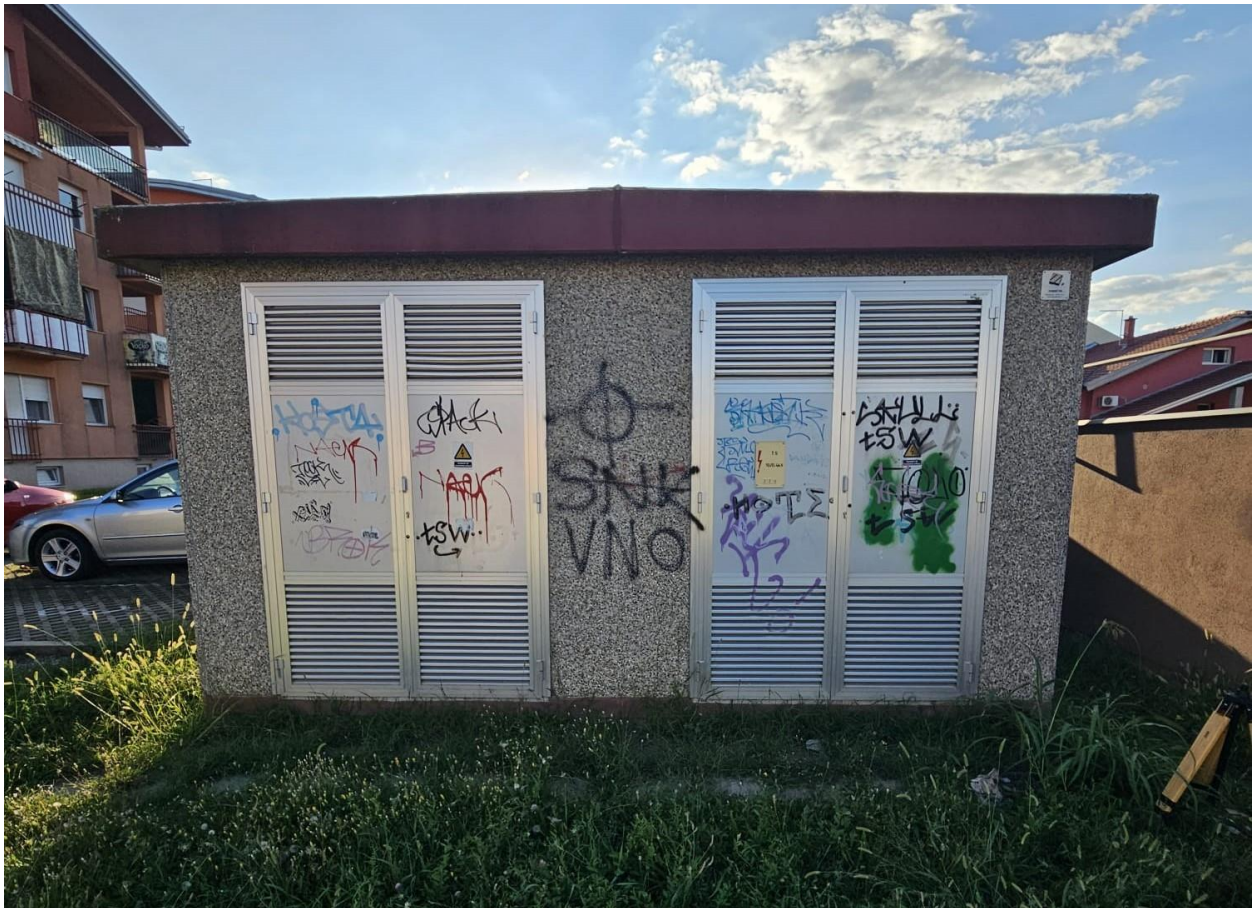
Slika 6.2. Transformatorska stanica KTS 220 Osijek 10/0,4 kV
