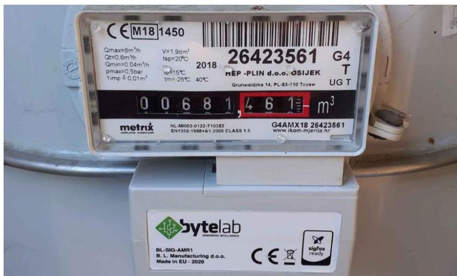
Slika 9. IoT uređaj spaja se na postojeći plinomjer[36]
