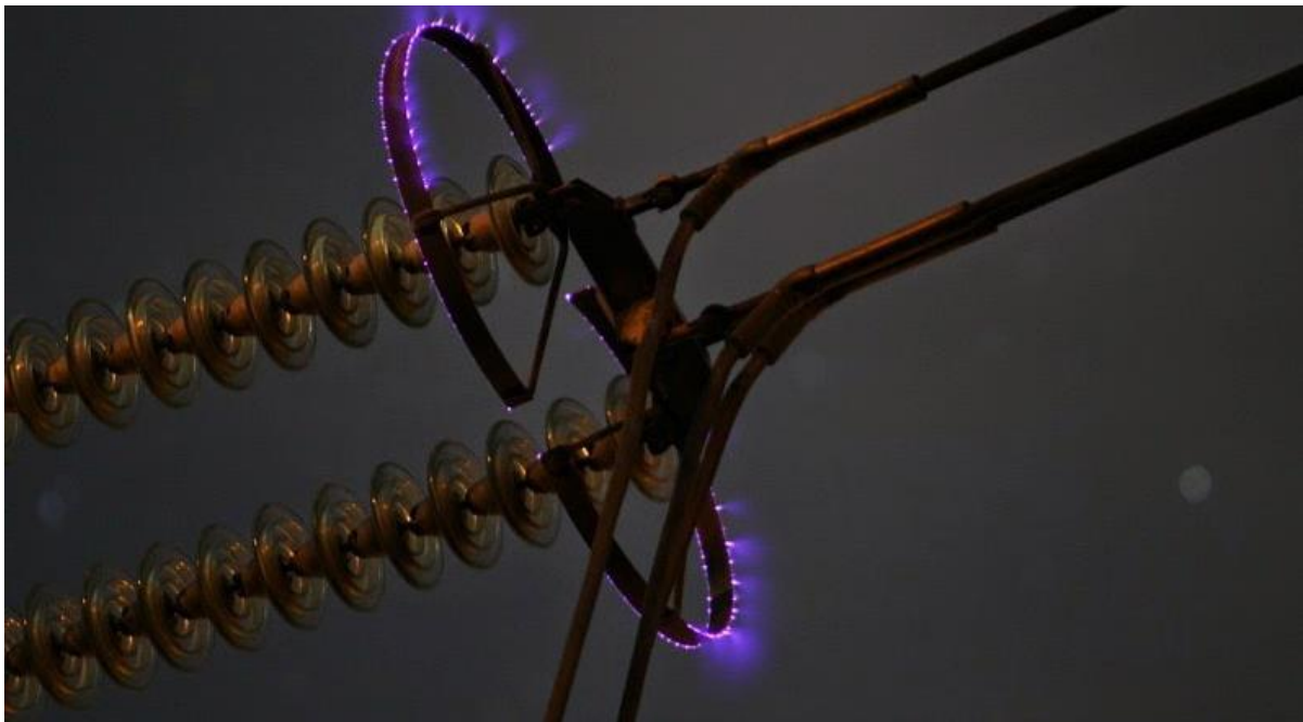
Slika 3.5. Prikaz korona efekta.[9]
