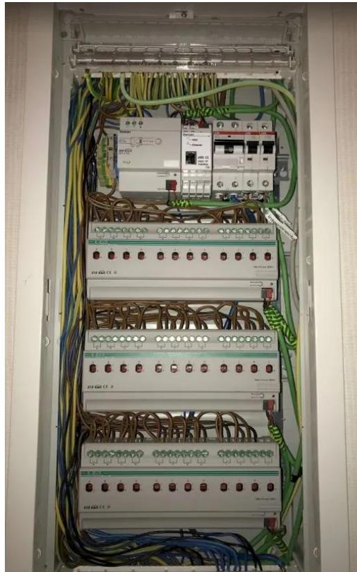
**Slika 2.6.** : Instalirani KNX sustav rasyjetnog centralnog distribucijskog ormara [23]
