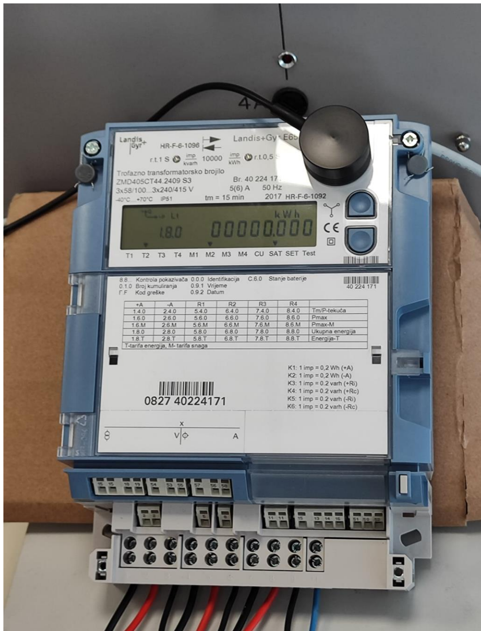
Slika 3.1. Landis+Gyr ZMD405CT44 brojilo električne energije
