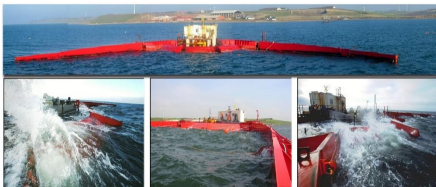
Slika 2.3 WaveDragon – primjer završnika. Reproducirano uz dopuštenje od [8]
