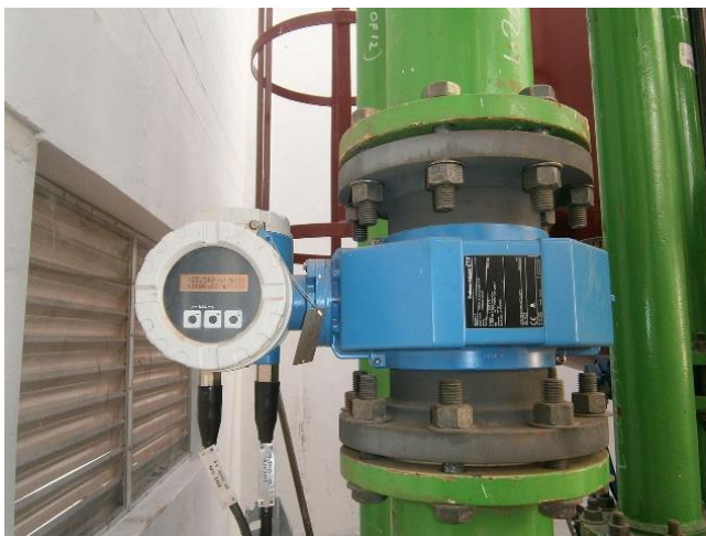
Slika 4.28 Doppler elektromagnetsko mjerilo [28]
