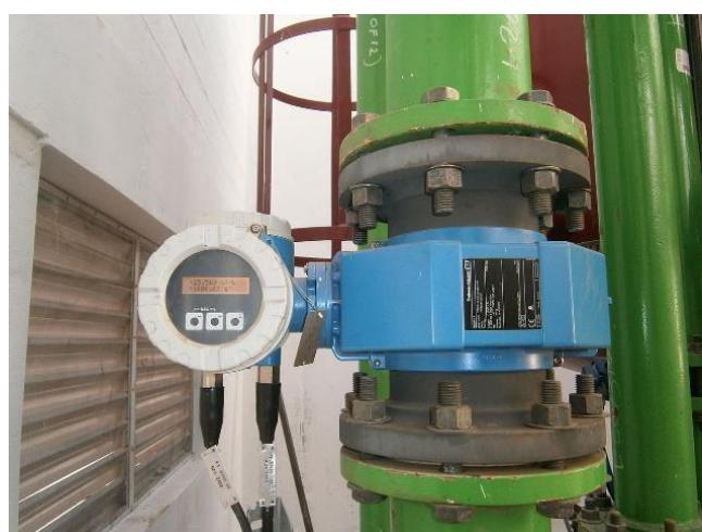
Slika 4.28 Doppler elektromagnetsko mjerilo [28]
