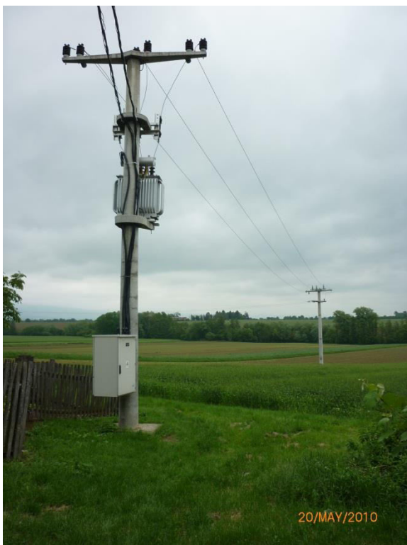
Slika 2-1 Trafostanica i transformator u Šeovcima
