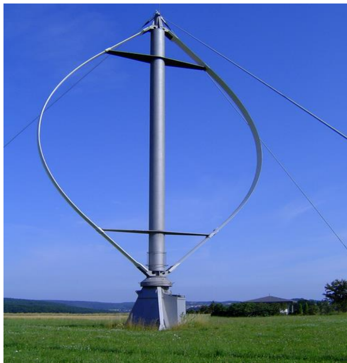
Slika 3.7. Darrieusova vjetroturbina [6]
