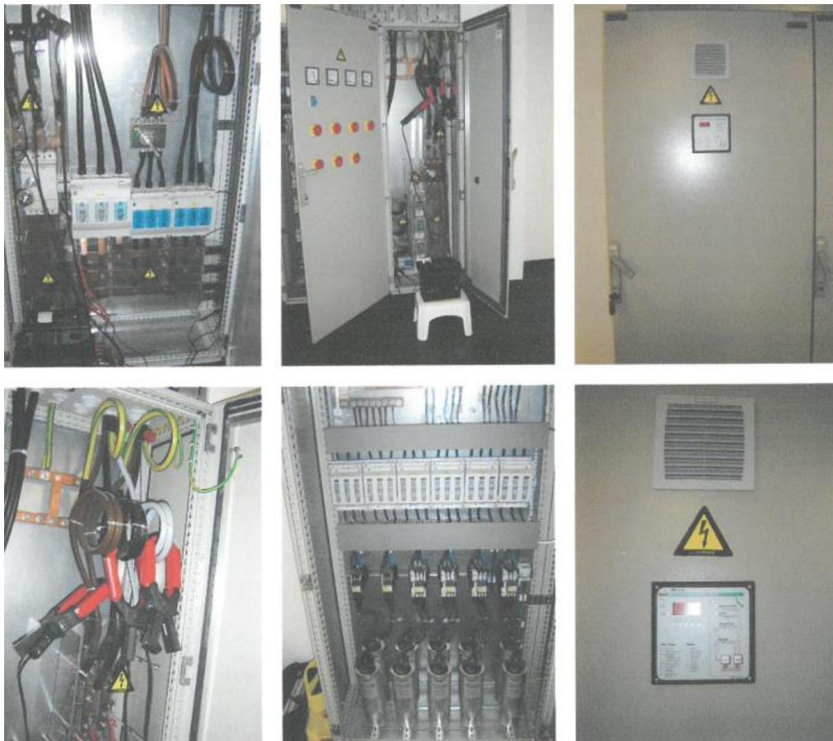
*Slika 4.8. Postupak mjerena elektroenergetski veličina na razvodnim ormarima [6]*
