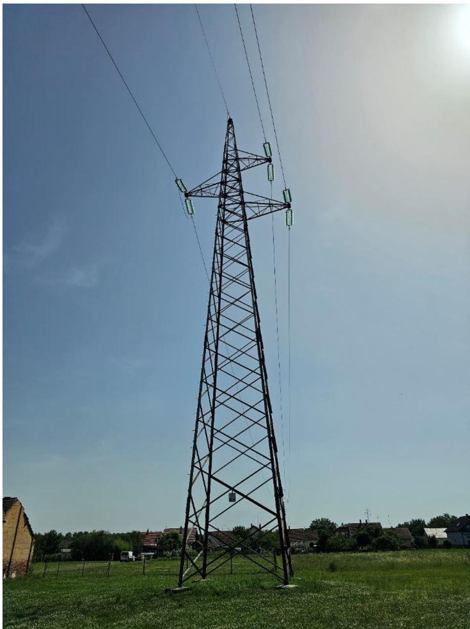
Slika 5.1. Stup broj 16, oblik stupa „jela“
