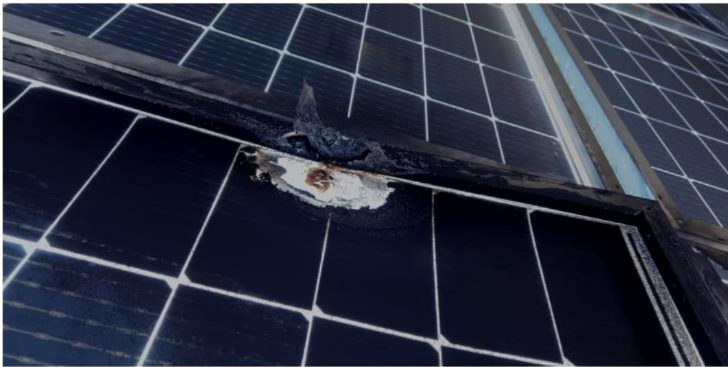
Slika 4.37. Oštećenje FN modula udarom groma [21]
