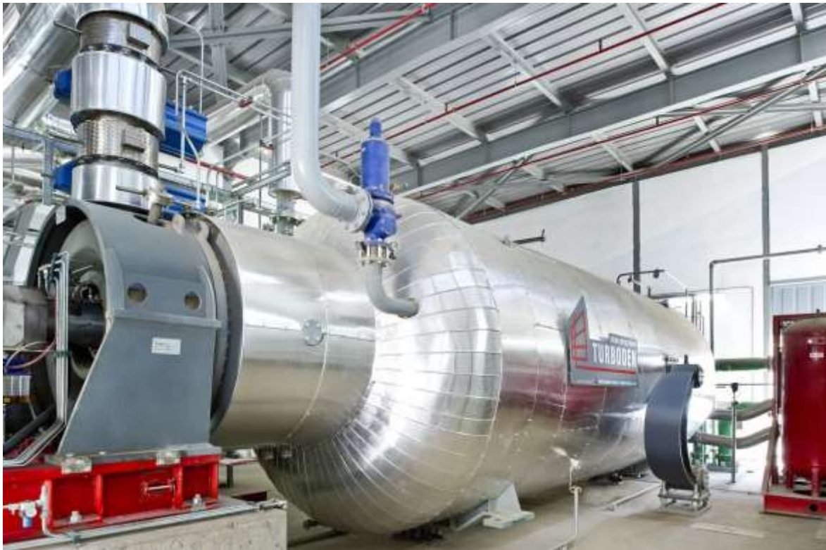
Slika 5.2. Organski Rankineov sustav (ORC) tvrtke Turboden [26]
