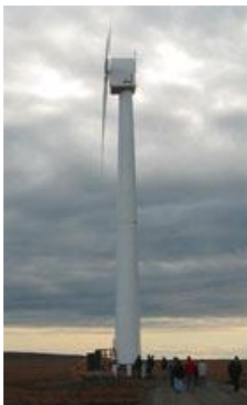
Slika 3.1 Turbina niz vjetar [11]
