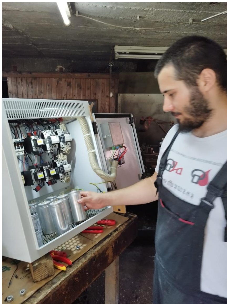
Slika 4.15 Ugradnja kondenzatorskih baterija
