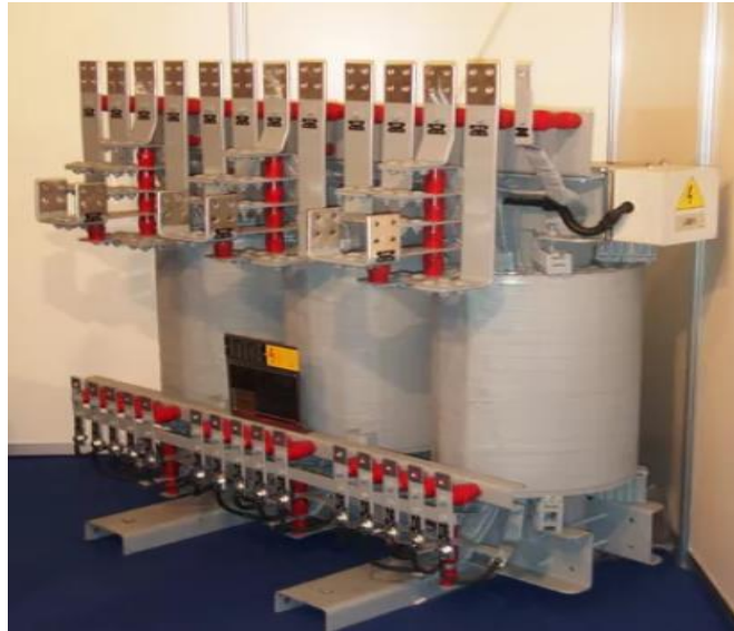
Slika 3.5. Autotransformator [42]
