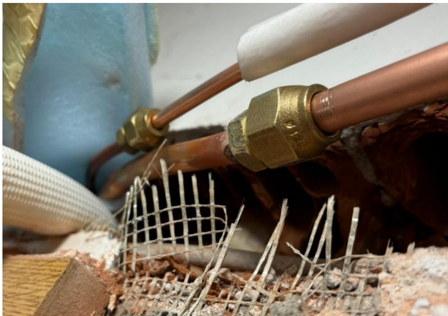
Slika 6.5. Spajanje bakrenih cijevi.
