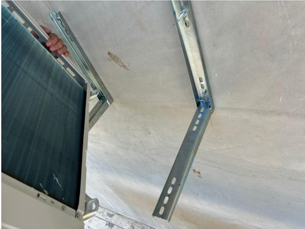
Slika 6.6. Postavljanje nosača za vanjsku jedinicu.
