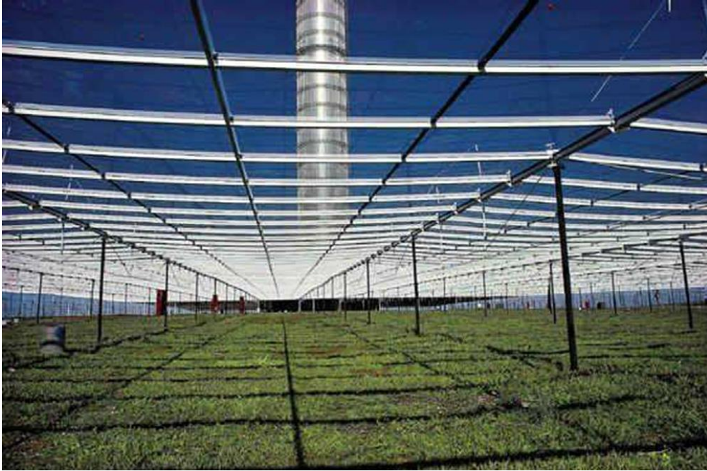
Sl. 3.13. Pilotno postrojenje u Manzanaresu, kolektor [5]
