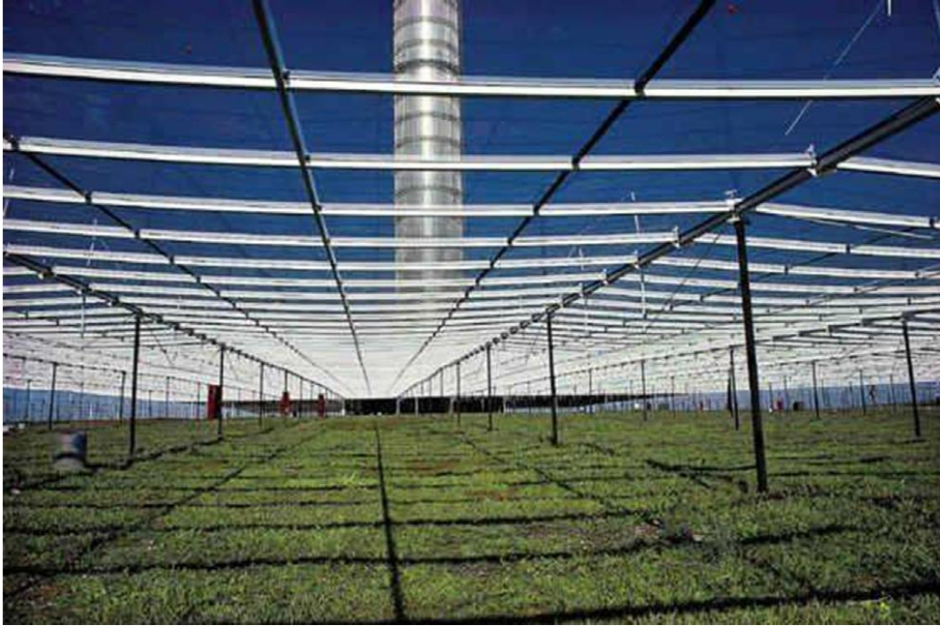
Sl. 3.13. Pilotno postrojenje u Manzanaresu, kolektor [5]
