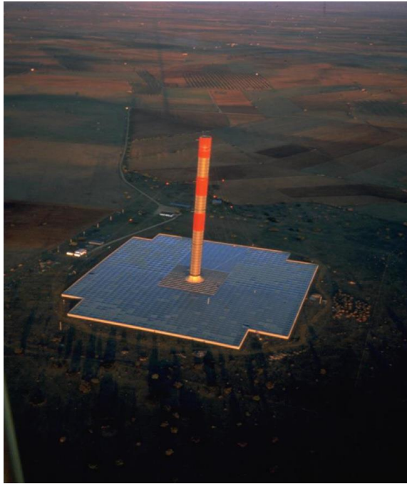
Sl. 3.15. Pilotno postrojenje u Manzanaresu, Španjolska [5]
