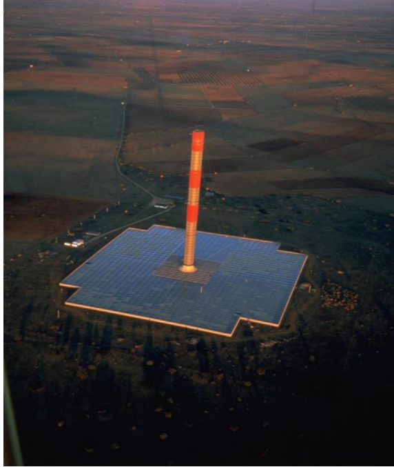
Sl. 3.15. Pilotno postrojenje u Manzanaresu, Španjolska [5]
