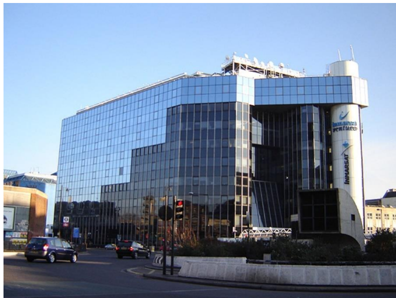
Slika 3.1. Zgrada Inmarsat-a u Londonu [9]
