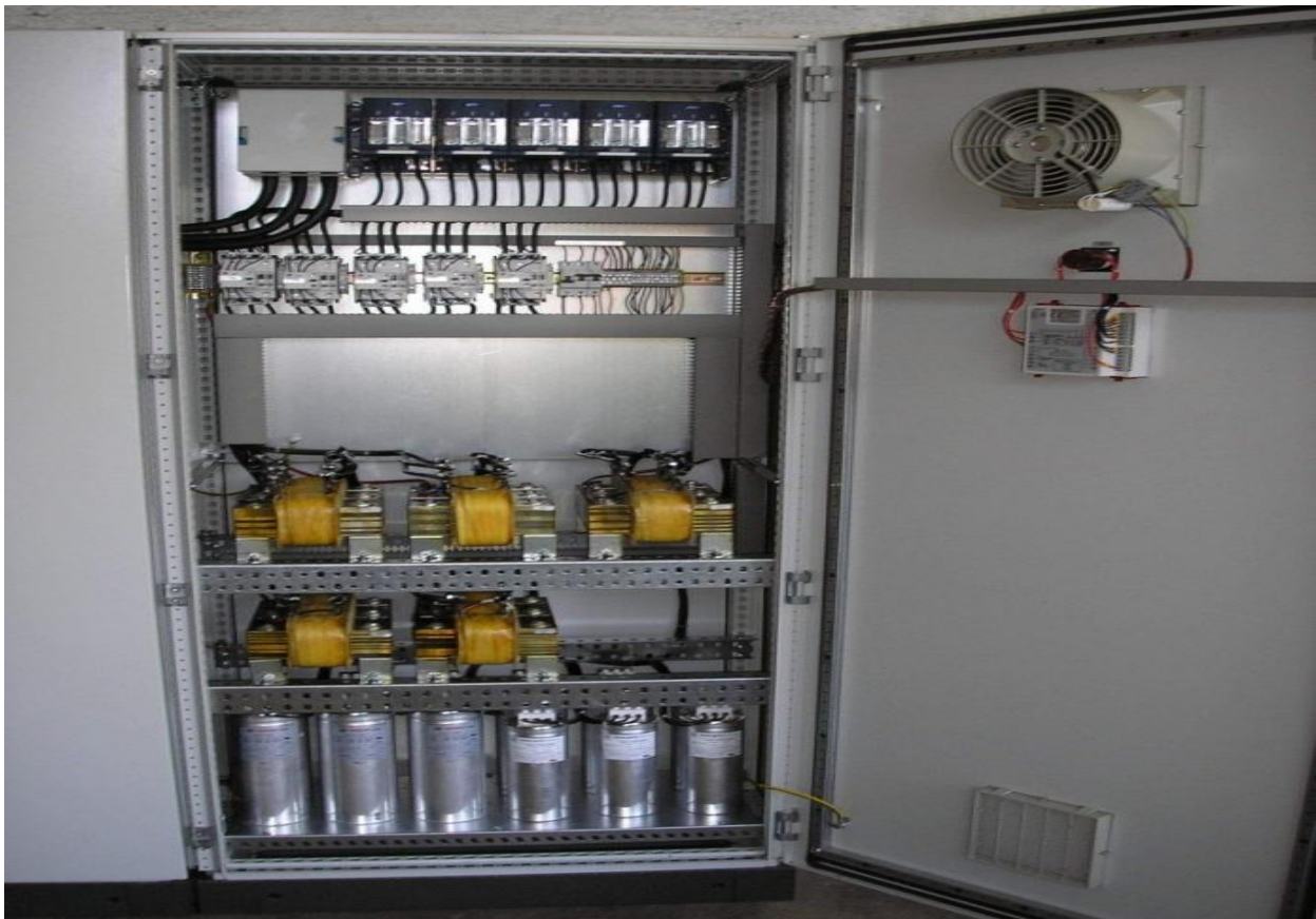
Slika 5.3. Uređaj za kompenzaciju jalove snage
