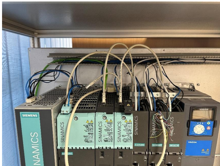
Sl. 6.3. Komunikacijski i naponski priključci koji služe za spajanje na sustav upravljanja.
