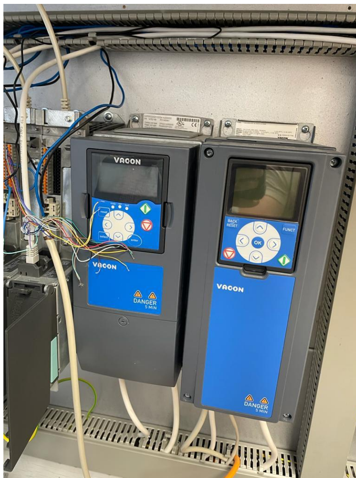
Sl. 6.4. Vacon frekvencijski pretvarači
