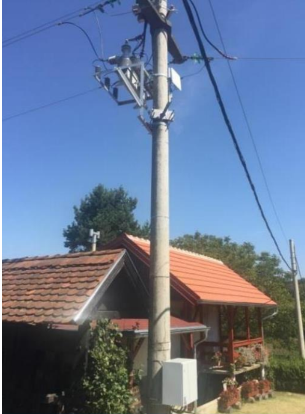
Slika 3-11 Simulacijski prikaz prekidača montiranog na stup (desno) i stvaran prikaz prekidača montiranog na betonski stup (lijevo) [5]
