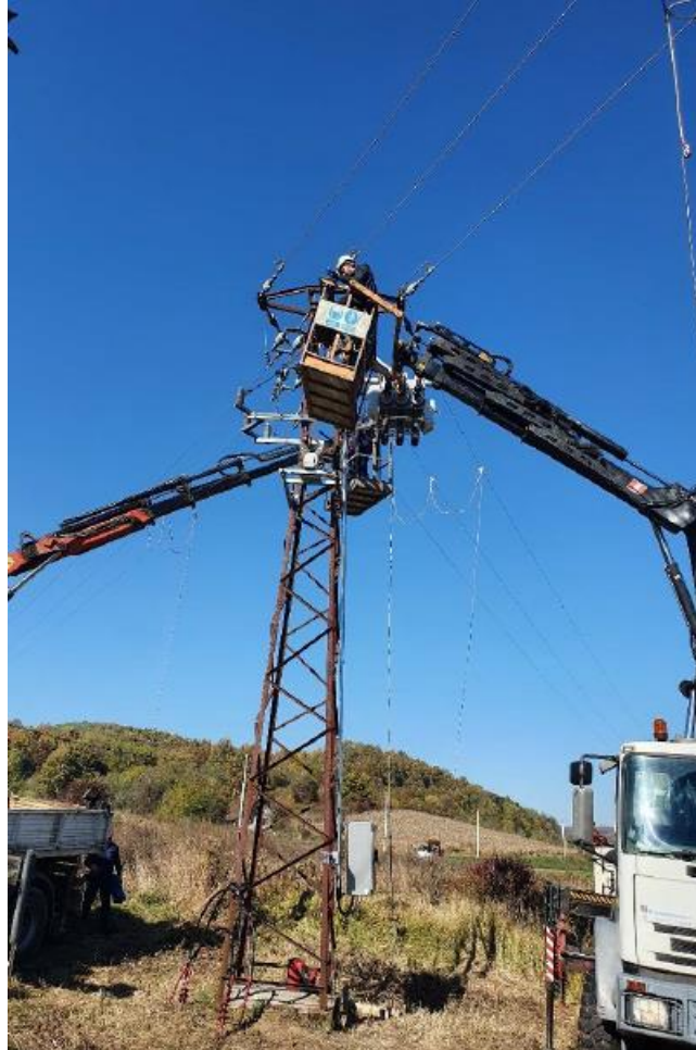
Slika 5-2 Montaza daljinski upravljive rastavne naprave na stup
