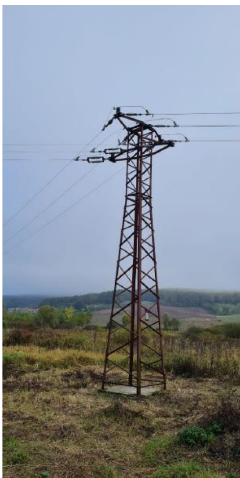
Slika 5-1 Stup prije postavljanja daljinski upravljive naprave
