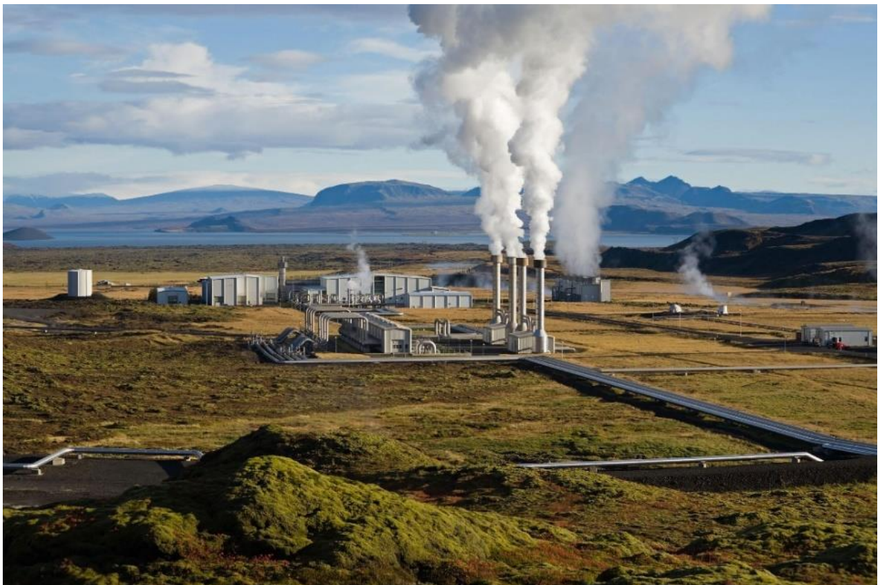
Slika 2.7. Geotermalna elektrana ispušta značajnu količinu vodne pare [29]
