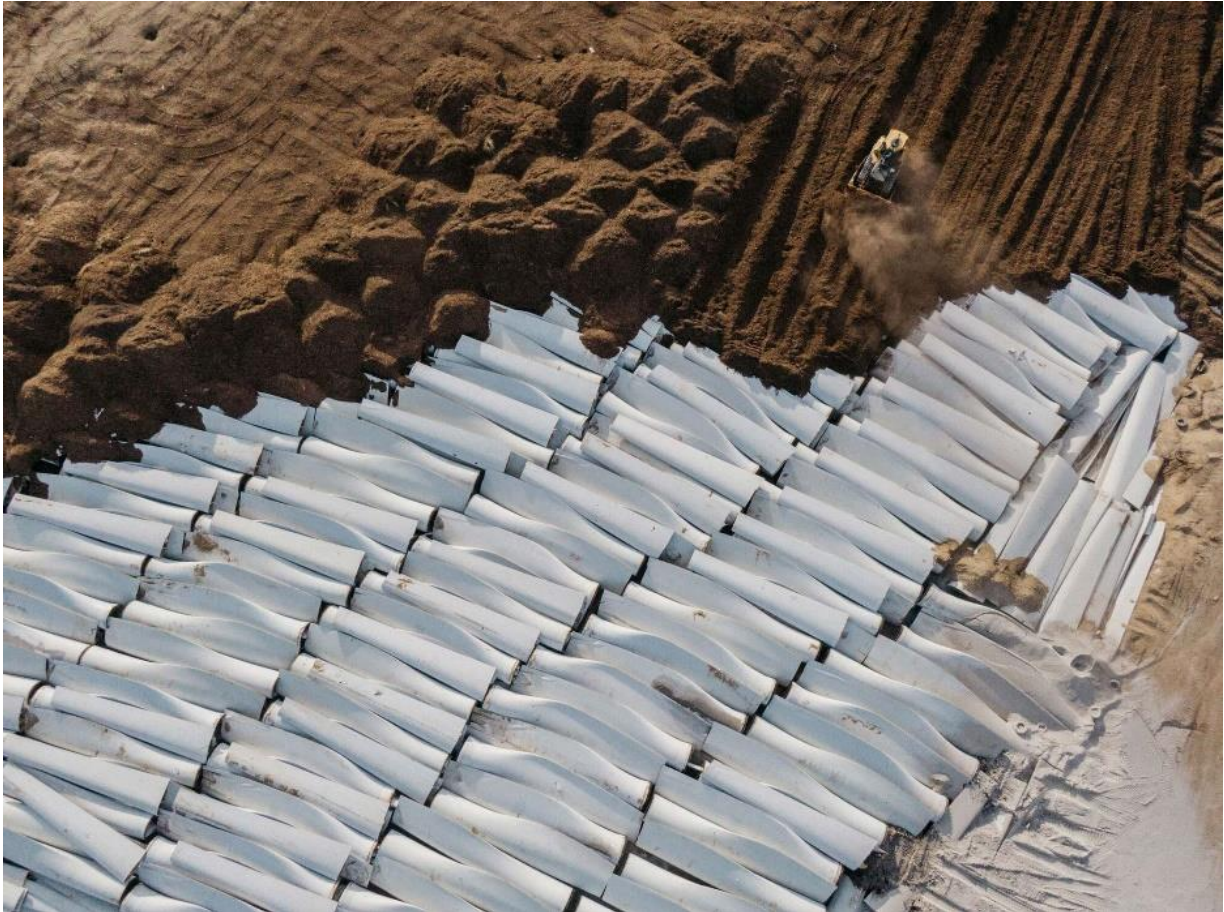
Slika 2.4. Zakopavanje lopatica vjetroturbina na odlagalištu otpada [18]
