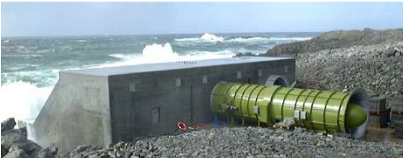
Slika 2.2.1. Postrojenje na morske valove Limpet u Škotskoj. [11]
