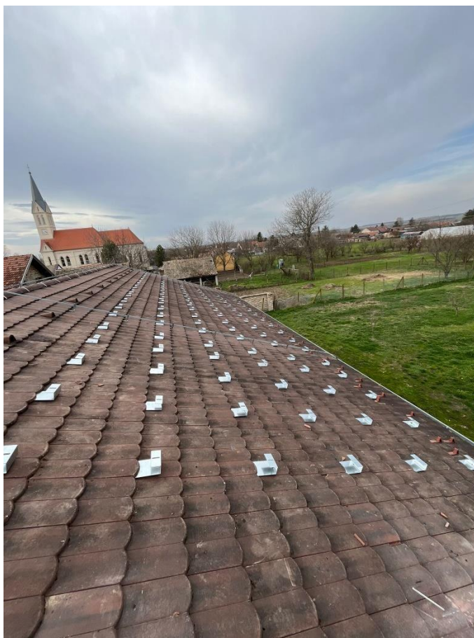
Slika 3.3 Prikaz postavljanja kuka na krov
