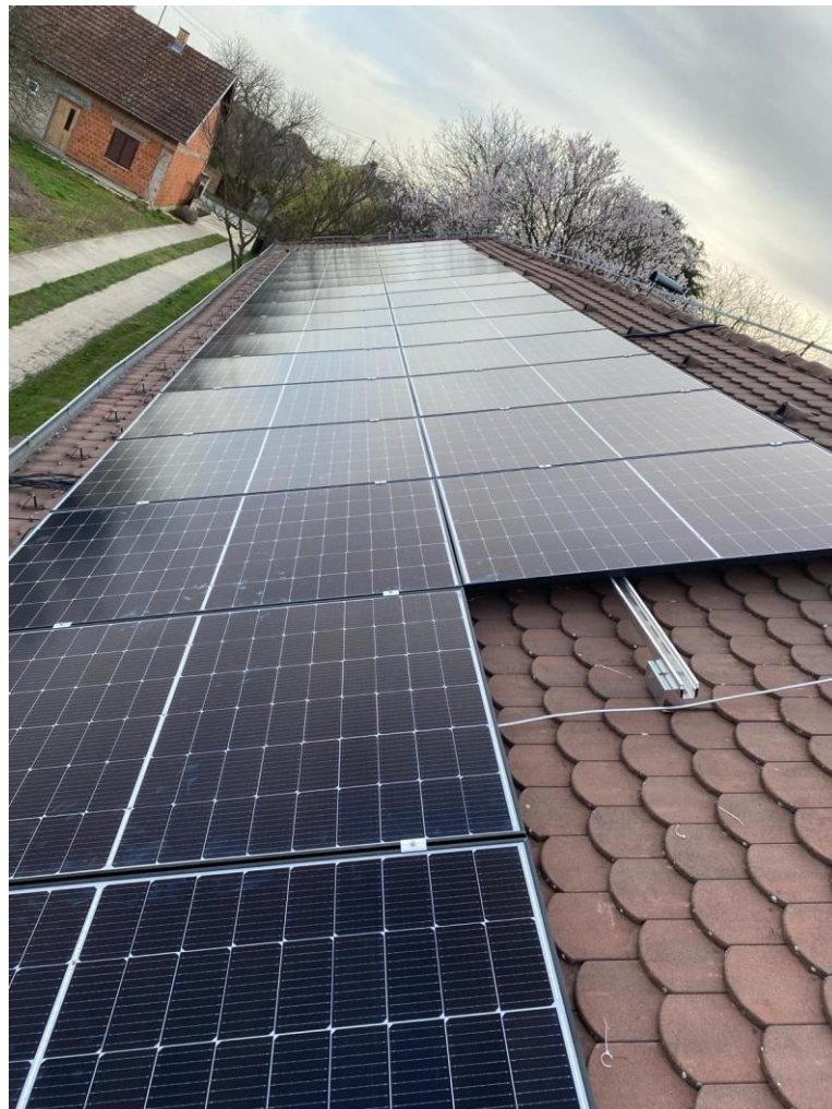
Slika 3.5 Prikaz postavljenih fotonaponskih modula na krov
