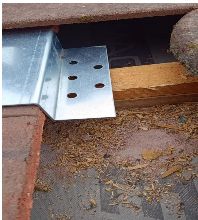
Slika 3.2 Prikaz postavljanja kuka na rog
