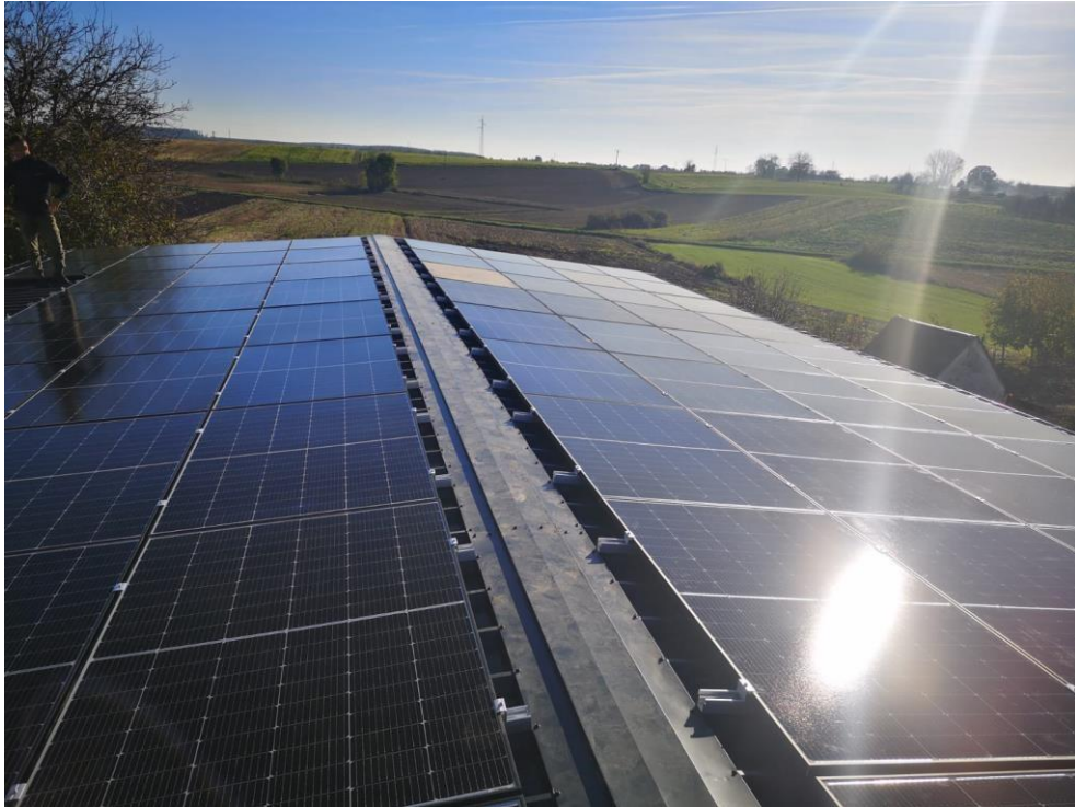
Slika 3.7 Prikaz postavljene fotonaponskih modula za trapezni lim
