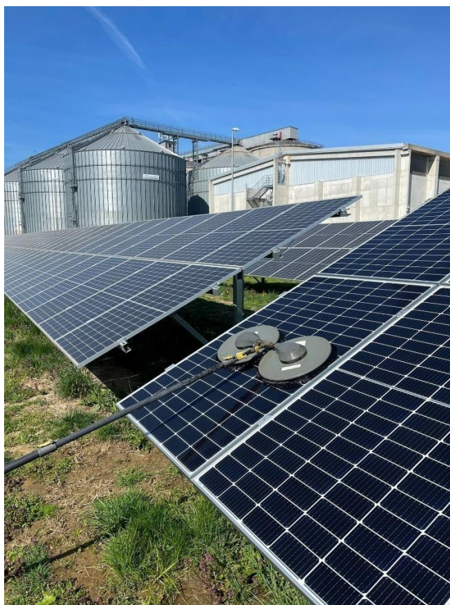
Slika 5.1 Prikaz čišćenja fotonaponskih modula
