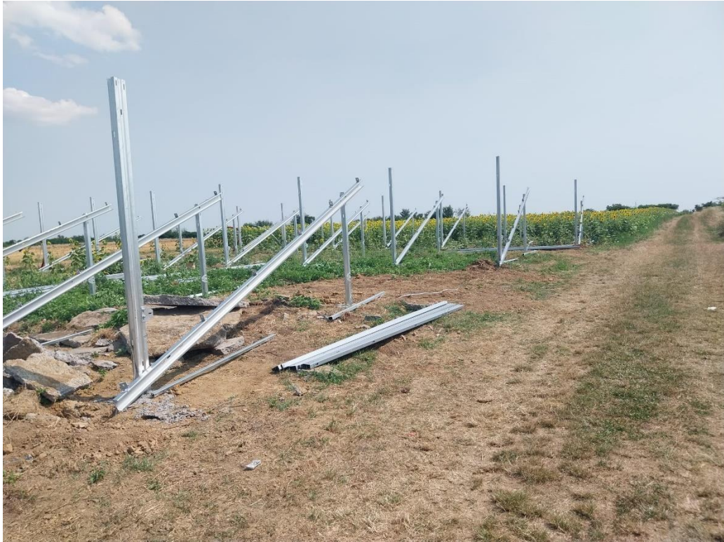
Slika 3.10 Prikaz postavljanja pod konstrukcije fotonaponskih modula na zemlji
