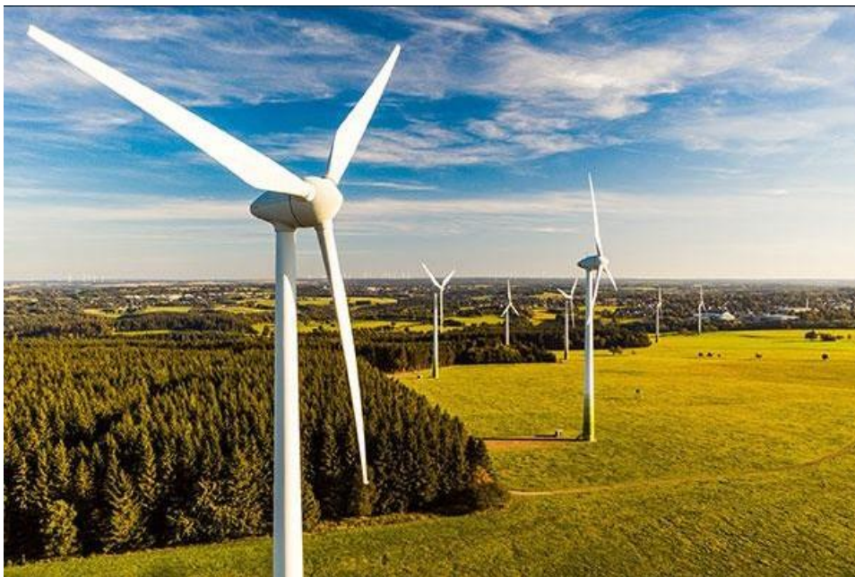
Slika 3.3 Vjetroturbina sa horizontalnom osi [28]
