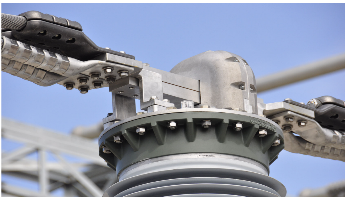
Slika 5.1.: Optički strujni mjerni transformator Trench [7]
