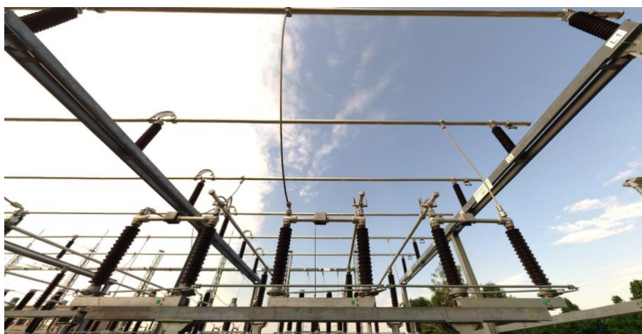
Slika 5.11. Struktura nosača i sabirnica.
