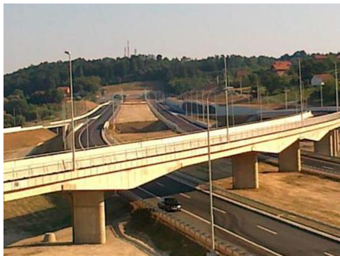
Sl. 3.2. Stupovi javne rasvjete, [7].
