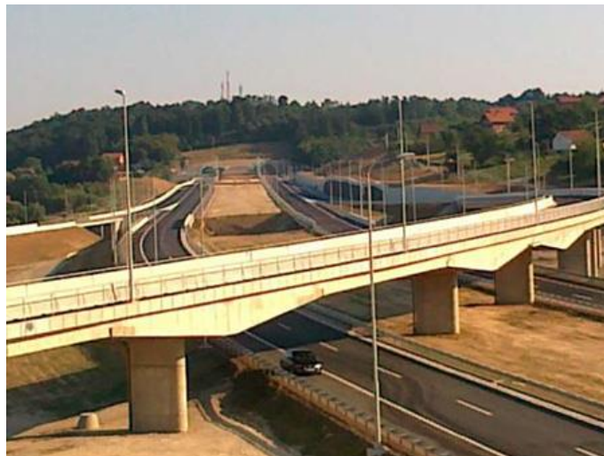
Sl. 3.2. Stupovi javne rasvjete, [7].
