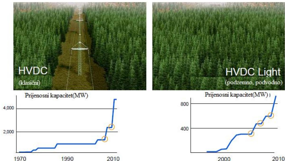
Slika 5.5. Usporedba klasičnog HVDC i HVDC Light[7]
