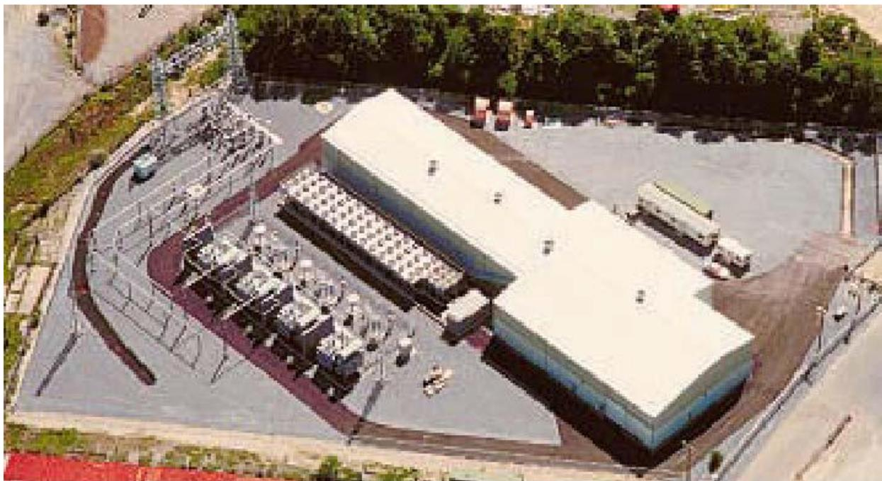
Pretvaračka stanica HVDC Light sustava u gradu Shorehamu, projekt pod imenom „Long Island Sound“, snage 330MW
