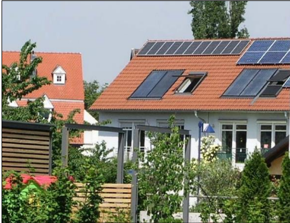
Sl. 4.1. Fotonaponski paneli na zemljištu u Mainheimu
