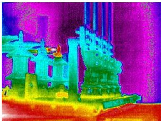
Slika 4.3.5. Spoj VN kabela na 10kV strani transformatora [4]
