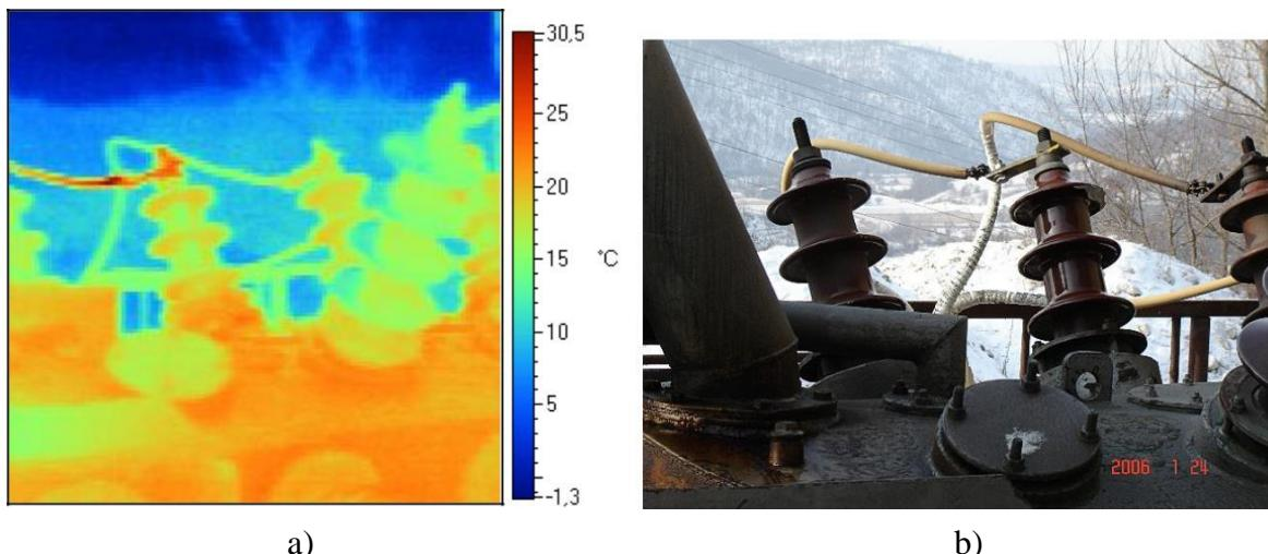
Slika 4.5.2. Termovizijski a) i vidljivi b) snimak kontakta izolatora 3 faze TS 35/10 kV [12]
