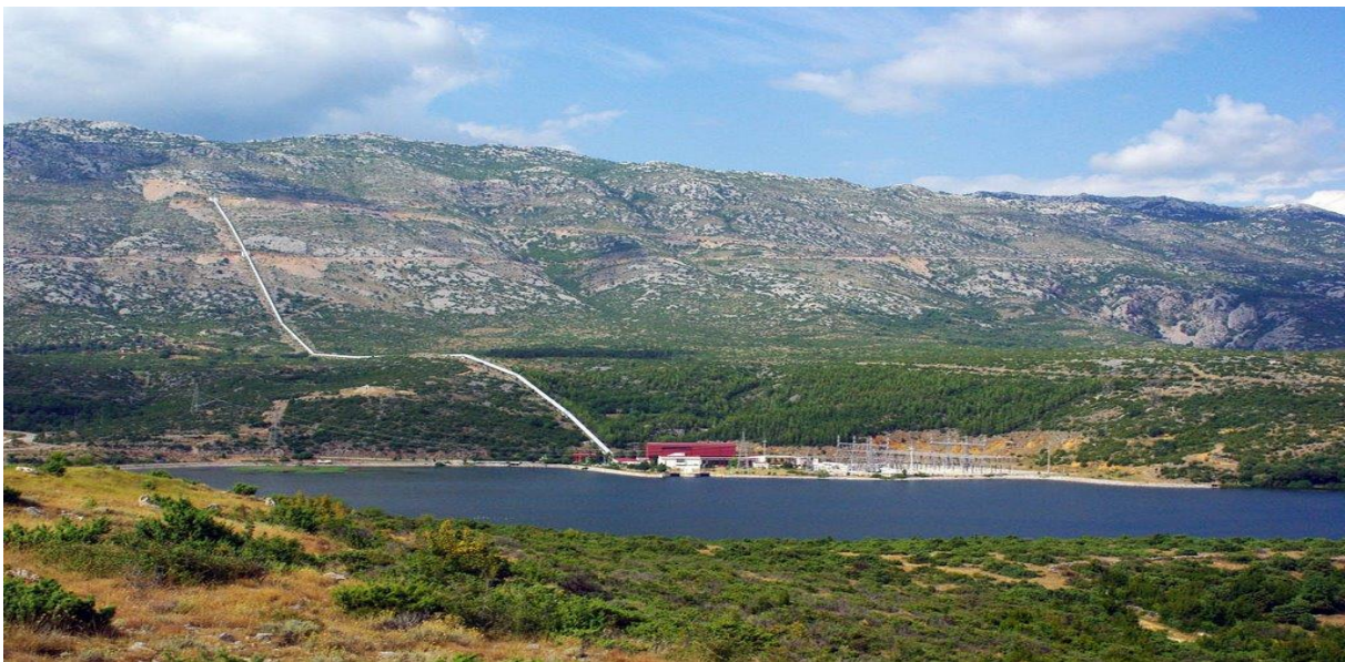
Slika 3.4. Pumpno-akumulacijska hidroelektrana RHE Velebit
