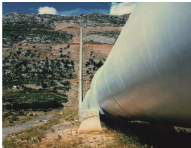
Slika 4.5. Čelični tlačni cjevovod RHE Velebit
