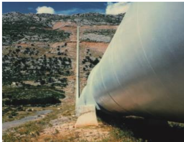
Slika 4.5. Čelični tlačni cjevovod RHE Velebit
