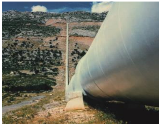
Slika 4.5. Čelični tlačni cjevovod RHE Velebit
