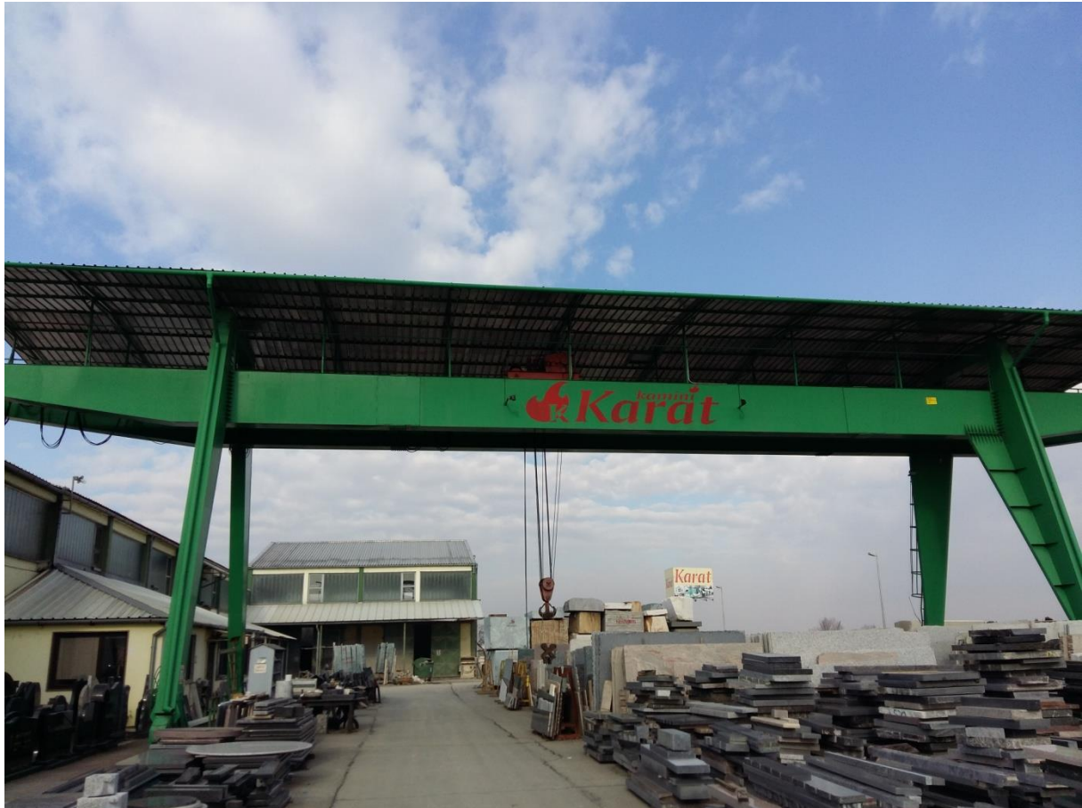
Slika 5.27. Velika kranska dizalica
