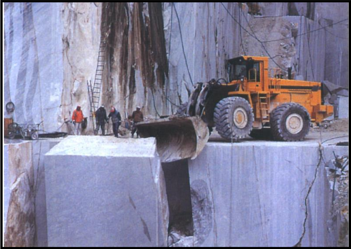
Slika 4.11. Rušenje primarnog bloka utovaračem
