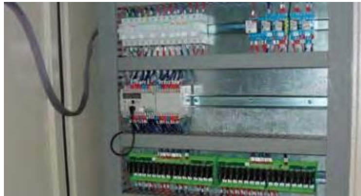
Slika 5.18. Sklopovi za kontrolu brzine
