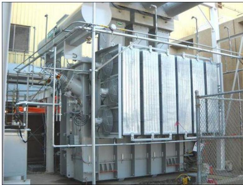
**Slika 3.8.** Trofazni transformator sa snagom 100 MVA
