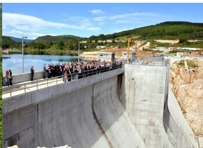
Slika 3.3. Betonska gravitacijska brana Lešće
