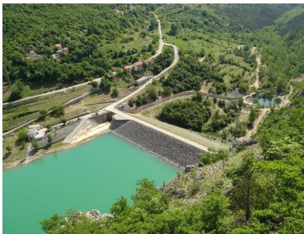
Slika 3.2. Nasuta kamenjem brana Ričica
