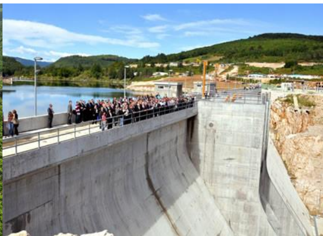
Slika 3.3. Betonska gravitacijska brana Lešće
