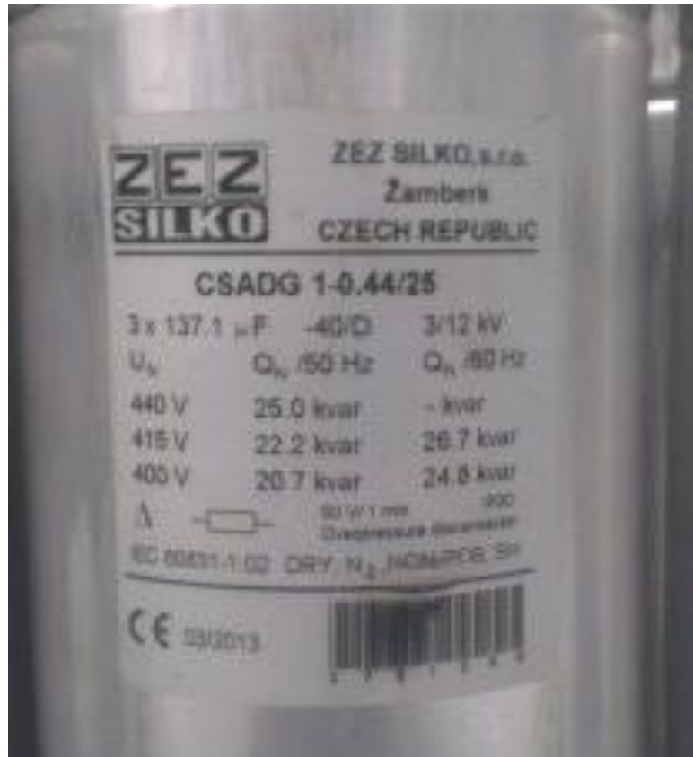
Slika 3.4. Natpisna pločica kondenzatorske baterije
