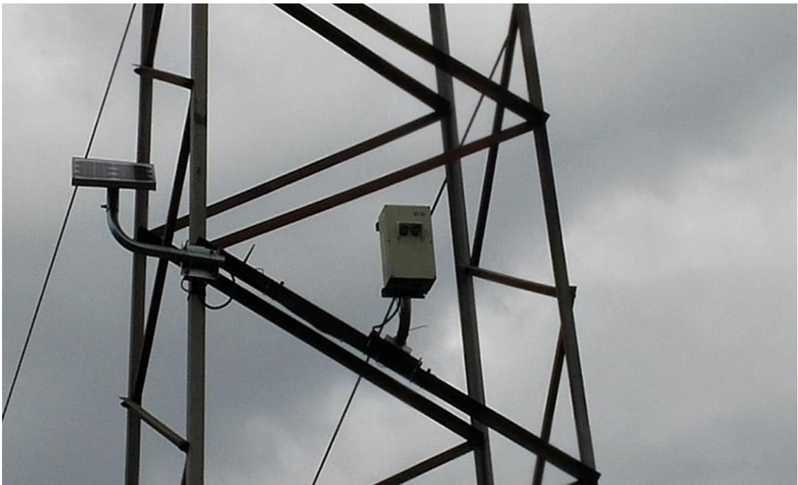
**Slika 3.3.** Indikator kvara SIK-30 sa solarnim napajanjem
