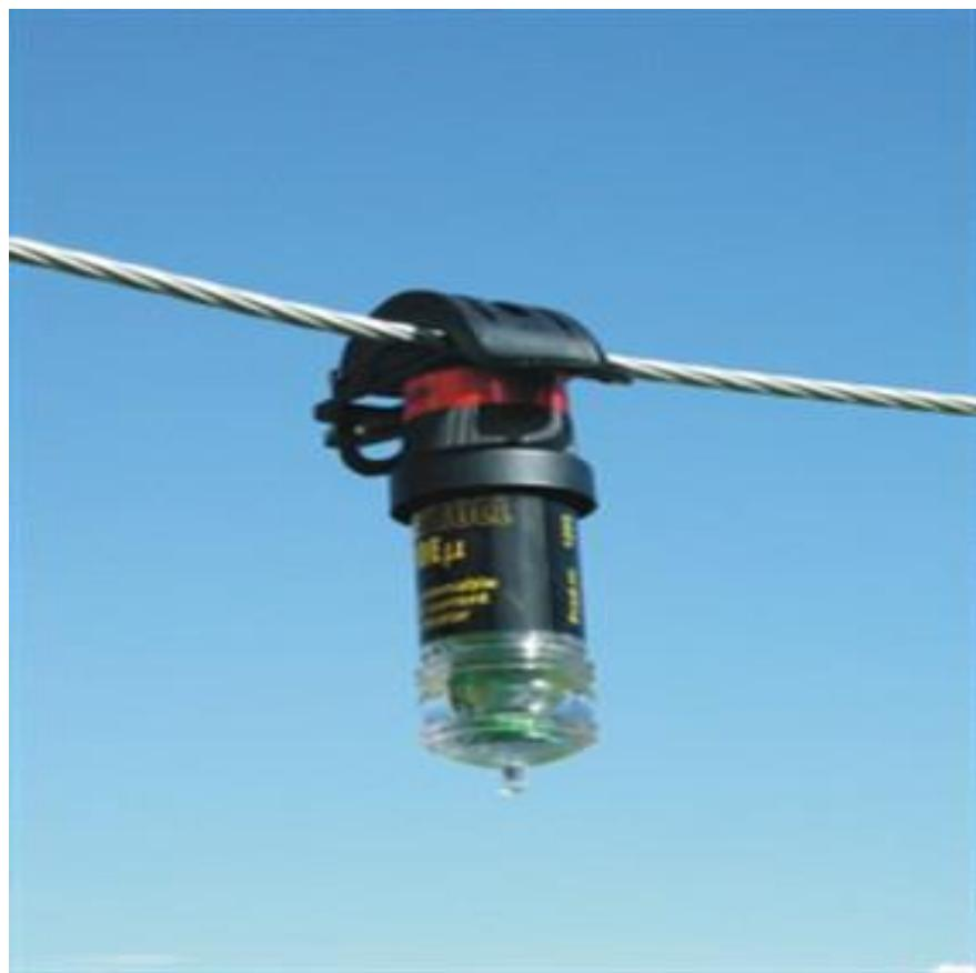
**Slika 2.4.** LineTroll 100E $\mu$  indikator kvara [4]
