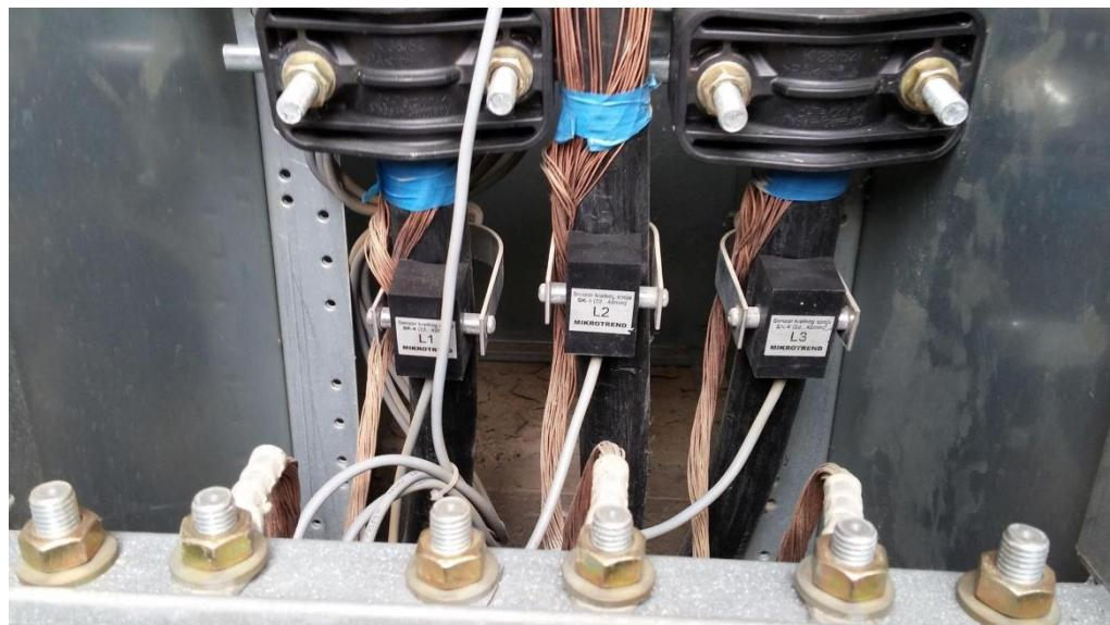
**Slika 2.10.** Strujni senzori montirani na kabelske završetke u razvodnom ormaru [11]
