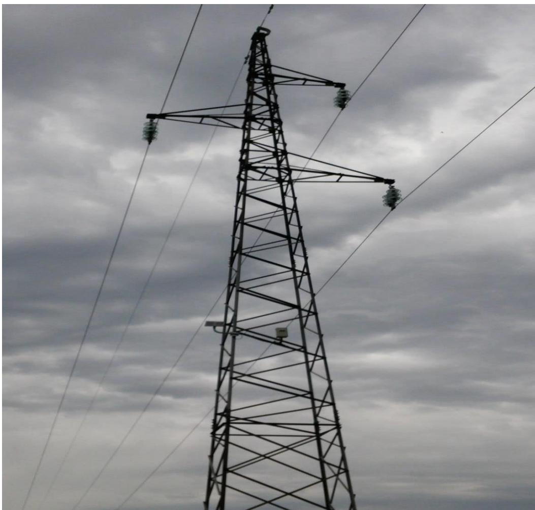
**Slika 3.2.** Indikator kvara SIK-30 montiran ispod vodiča 35 kV
