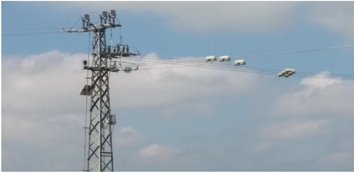
**Slika 3.10.** Indikator kvara MEg61.4 sa senzorima na vodičima
