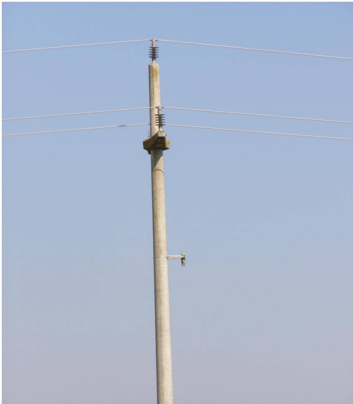
**Slika 2.6.** LineTroll indikator montiran na stup ispod vodiča [11]
