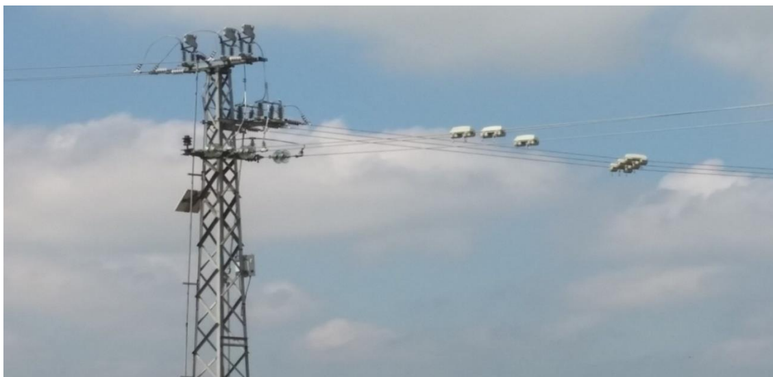
Slika 3.10. Indikator kvara MEg61.4 sa sensorima na vodičima
