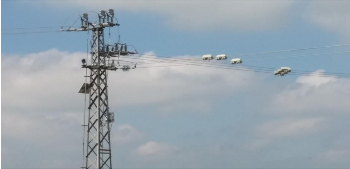
Slika 3.10. Indikator kvara MEg61.4 sa sensorima na vodičima
