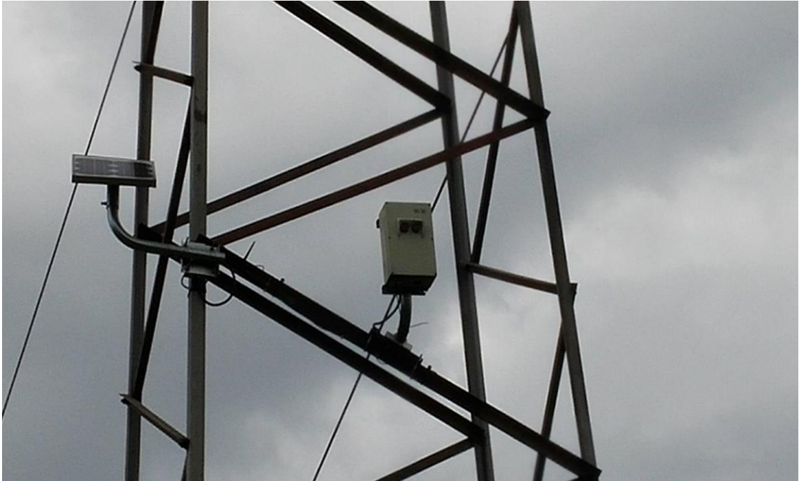
Slika 3.3. Indikator kvara SIK-30 sa solarnim napajanjem
