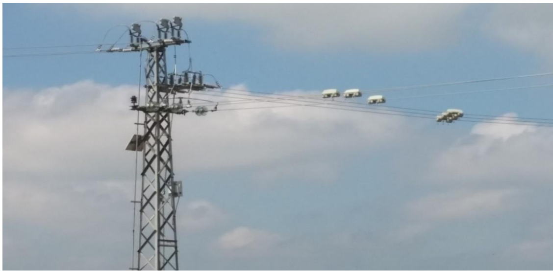
Slika 3.10. Indikator kvara MEg61.4 sa sensorima na vodičima
