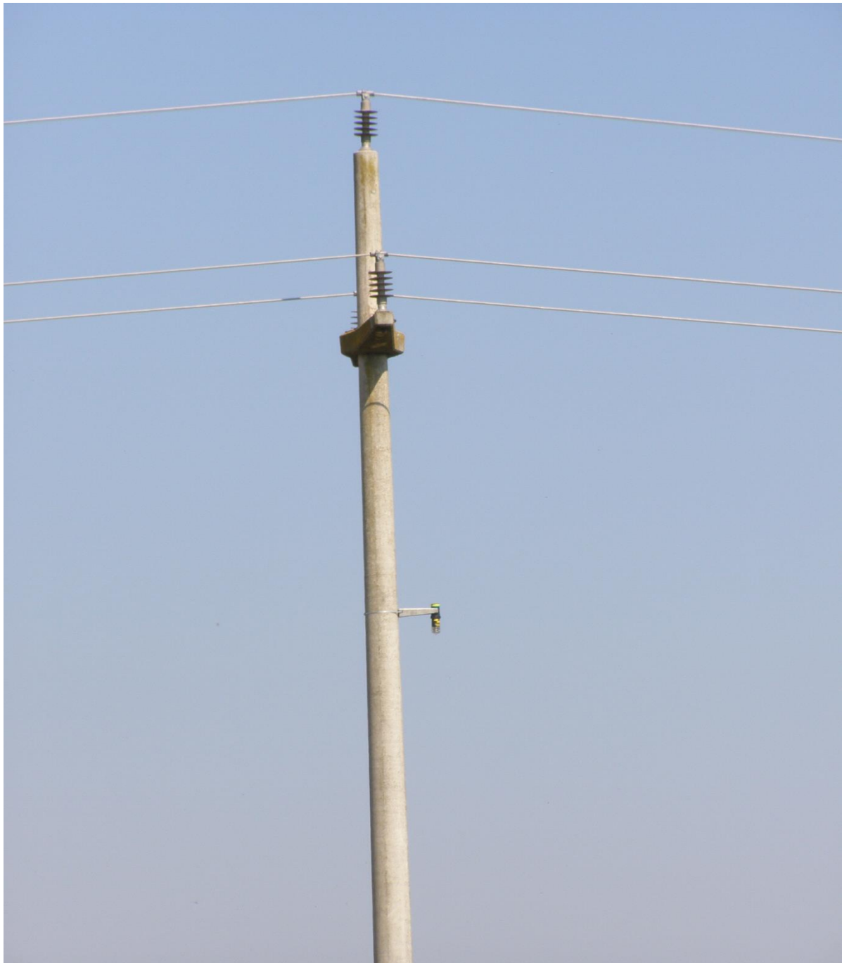
Slika 2.6. LineTroll indikator montiran na stup ispod vodiča [11]
