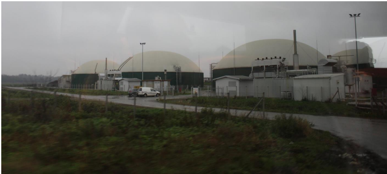
Slika 3.8. Bioplinska elektrana Mala Branjevina.
