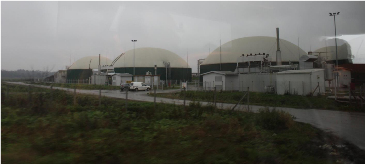
Slika 3.8. Bioplinska elektrana Mala Branjevina.
