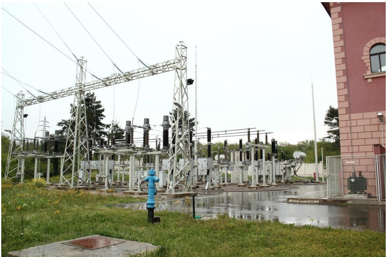
Slika 5.2. Trafostanica Vinčent 110/20kV snage 40MVA
