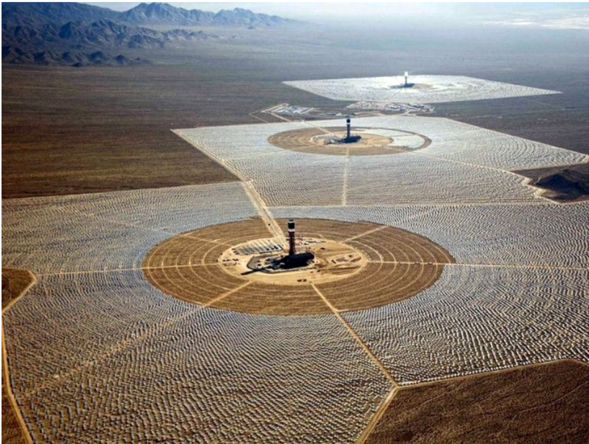
Slika 3.7. Ivanpah solarna elektrana u Kaliforniji [20]
