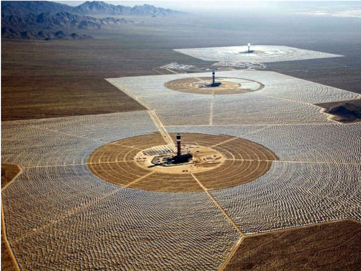
Slika 3.7. Ivanpah solarna elektrana u Kaliforniji [20]
