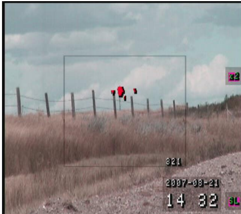
Slika 8.6. Prikaz korone na slici UV kamerom
