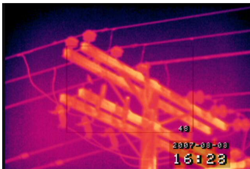
Slika 8.5. Prikaz dalekovoda infracrvenom kamerom u infracrvenim bojama
