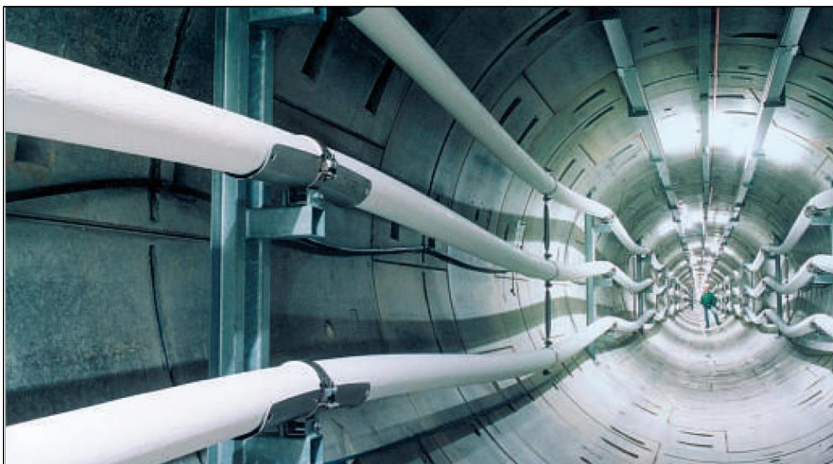
**Slika 3.1.** 400 kV kabelski sustav u tunelu duljine 6.3 km ispod centra Berlina
